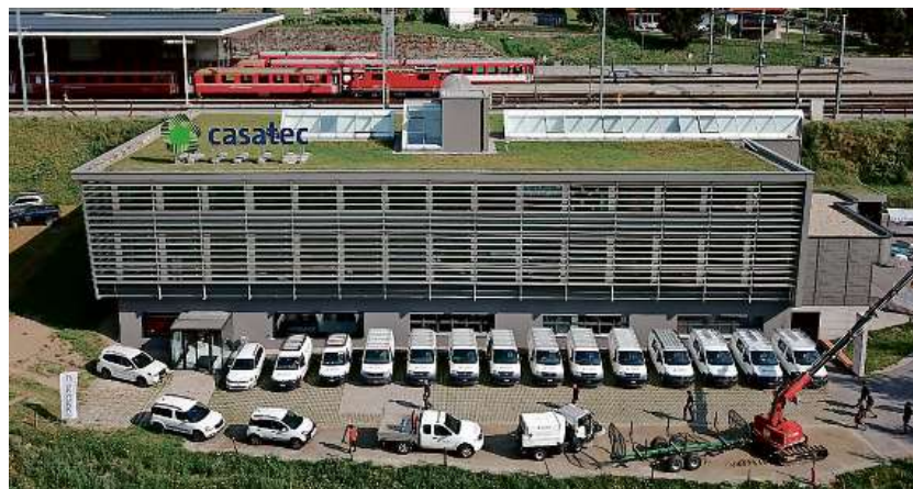
Modernisiert: Zwei Jahre dauerte der Umbau des Gebäudes.
